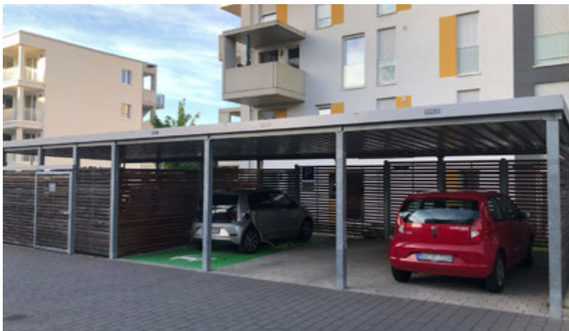
Durch technische Elemente mit Dachbegrü- nung verschatteter Parkplatz (Baden-Baden) [1]
