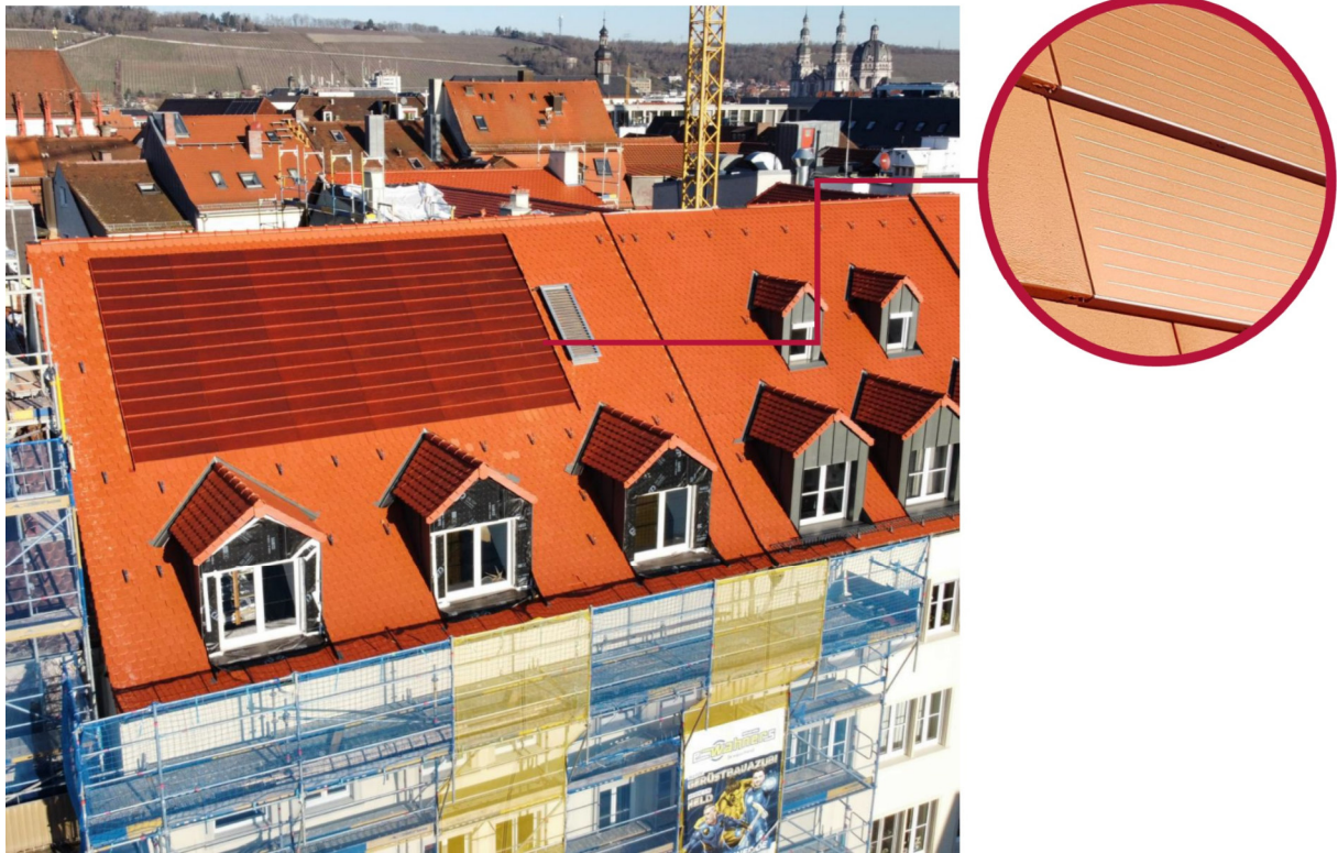
Abbildung 5: Modehaus Schlier mit Planum PV Modulen der Fa. Nelskamp, Quelle: Nelskamp
