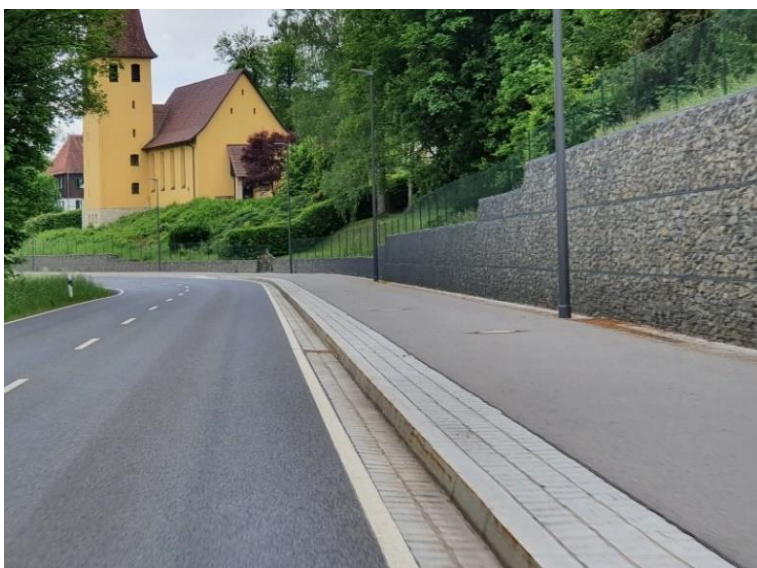
Abb. 45: Neuer, straßenbegleitender Radweg bei Tambach
