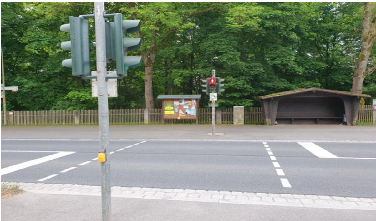
Abb. 50: Signalisierte Querung mit fehlender Streuscheibe für Radverkehr am Ende des gem. Geh-/Radweges östl. von Schloss Tambach
