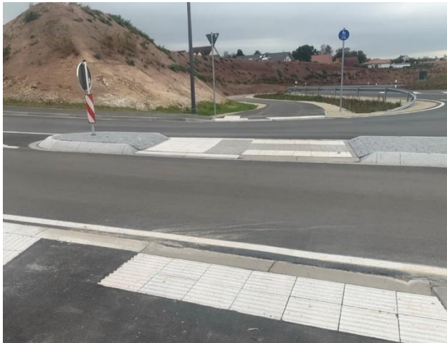
Abb. 49: Doppelquerung mit 6 und 0 cm Bordhöhe inkl. Aufmerksamkeitsfelder
