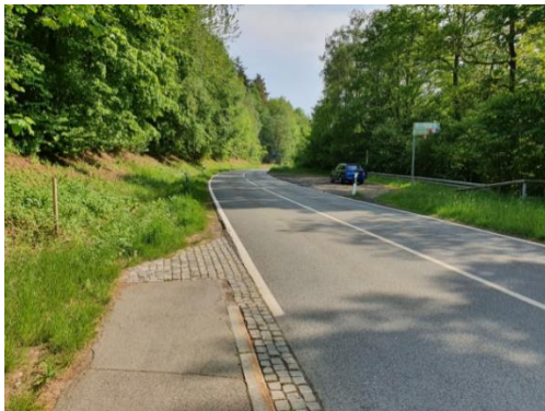
Abb. 24: Fehlende Querungshilfe südöstl. des Froschgrundsees (M_P2)
