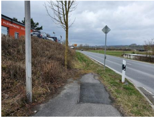
Abb. 22: Fehlende Radverkehrsanlage südl. von Untersiemau (M_S15)
