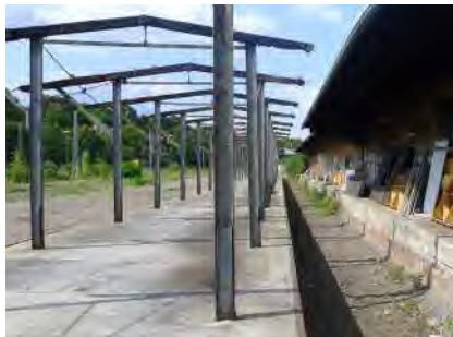
Rückseite der leerstehenden Stückguthalle im zentralen Bereich
