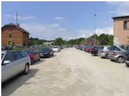
Wassergebundene Decke im zentralen Bereich vorwiegend als Parkfläche genutzt
