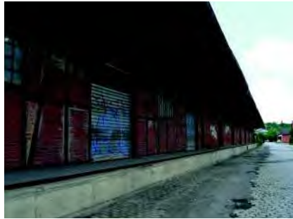
Ortsbildprägendes Gebäude Stückguthalle
