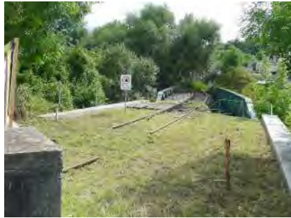
5: Ortsbildprägend: Die sog. „SÜC“-Brücke, eine ehemalige Gleisverbindung über die Itz
