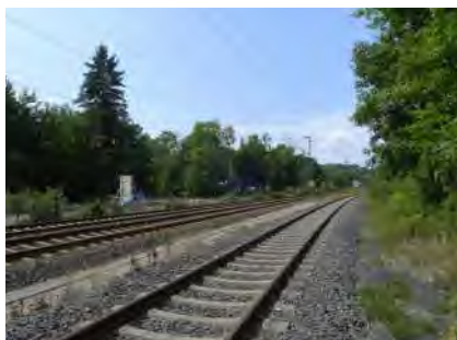
Prägende Gleisanlagen, räumliche Barriere nach Westen
