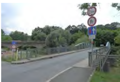
Eingeschränkter Zugang zum Gebiet über die Wassergasse - der Schafsteg
