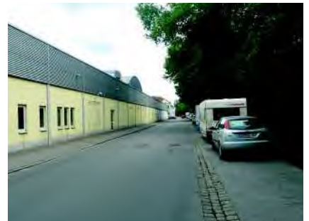
Gebäuderückseiten entlang der Uferstraße
