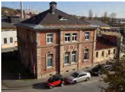
Baudenkmal: U.a. das Verwaltungsgebäude des ehemaligen Schlachthofs
