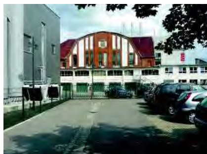
Lärmemissionen BHKW der SÜC
