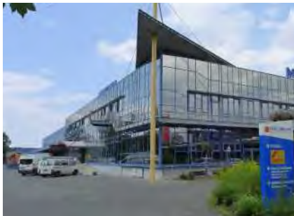
Max-Carl Haustechnik im Süden, neuer Standort der Firma Ros
