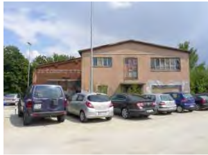
Sehr schlechter Gebäudezustand: Anbau am Lokschuppen
