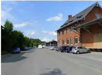
Mäßiger Zustand: Das Zollgebäude an der Schlachthofstraße
