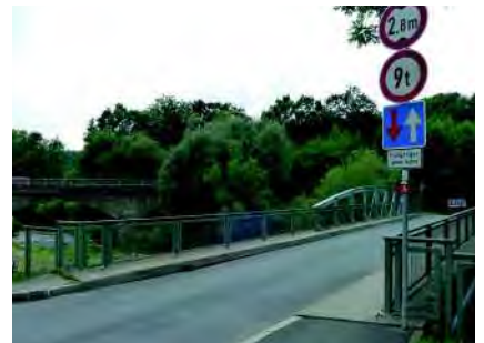
Mangelnde Leistungsfähigkeit für den Verkehr im Süden
