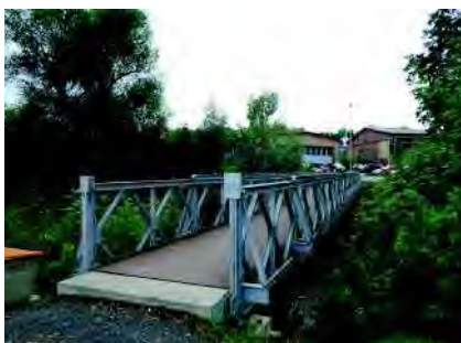
Temporärer Zugang Brose-Fußgängersteg über die Itz in das Planungsgebiet
